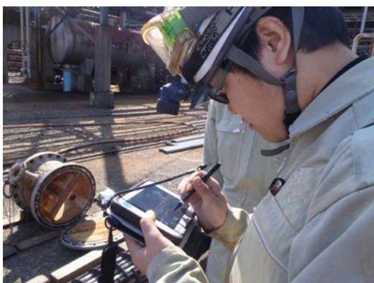
写真-2 現場作業風景（目視検査）
