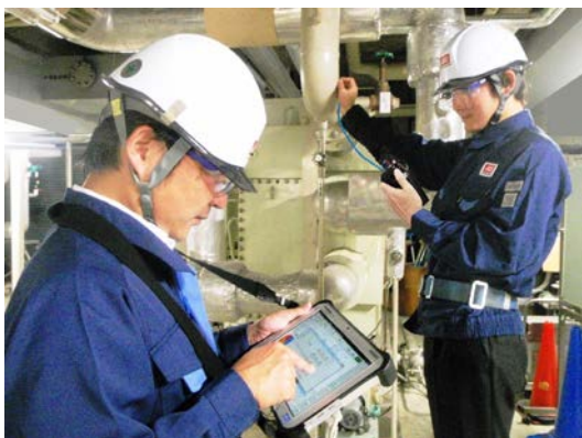
写真-1 現場作業風景（肉厚測定）
